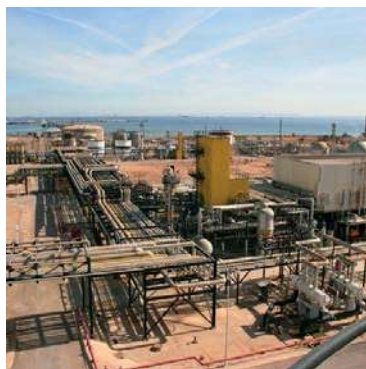
SONATRACH LPG HASSI MESSAOUD, CONTRACT DE SOUS
